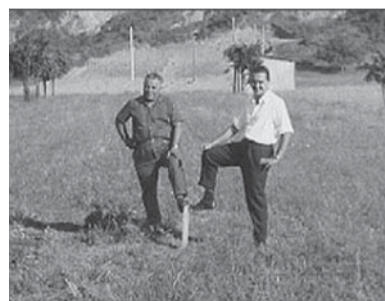
Agosto 1961, viene posato dal dott. Fausto Pascoletti il primo "picchetto" per la recinzione su cui verrà edificato l'attuale Stabilimento Alfa a Ponte San Giovanni, in via della Valtiera (Pg).
