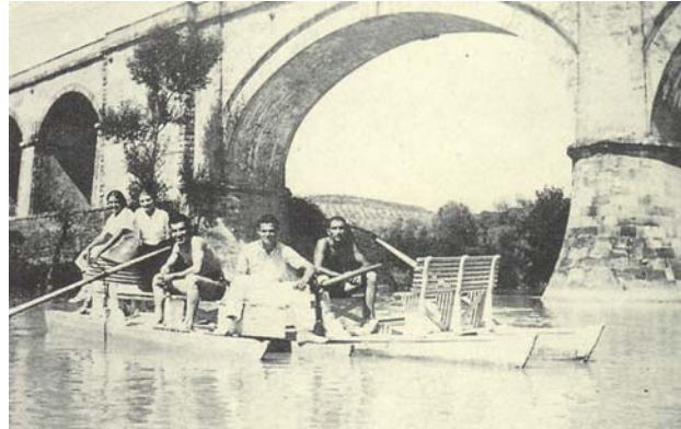
Foto tratta dal volume "Ponte San Giovanni, visto e raccontato" stampato nell'ottobre 1990.
