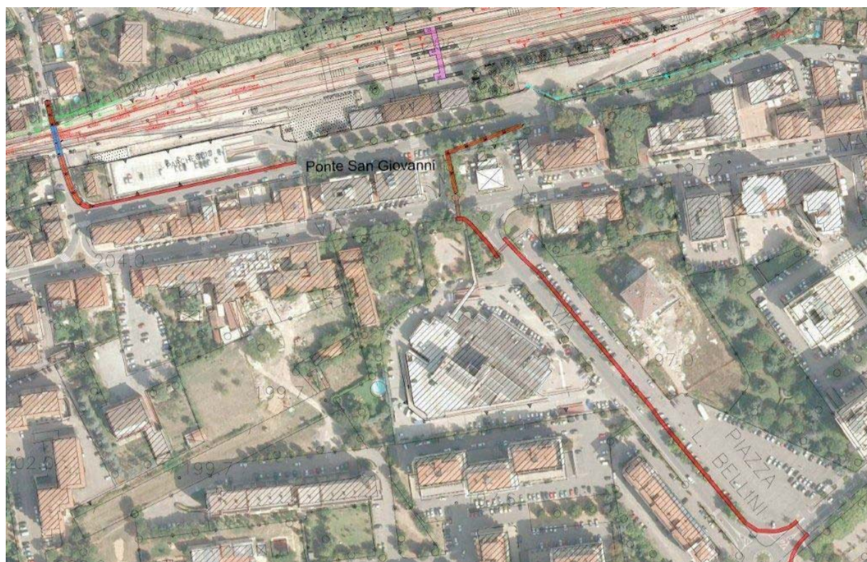
Panoramica del progetto integrato della stazione ferroviaria di Ponte San Giovanni
