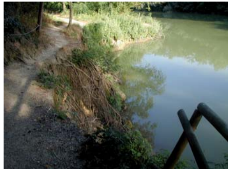
Tratto del percorso franato
