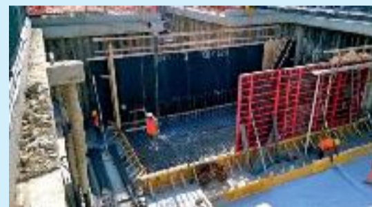
I lavori di costruzione dello scatoletto monolitico di calcestruzzo all'interno della fossa di varo
