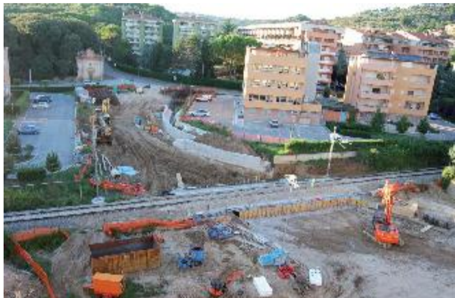
Veduta aerea dei lavori
