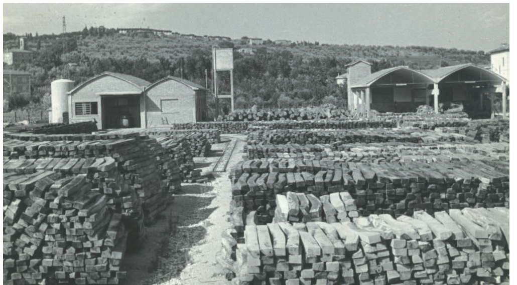
Una veduta del piazzale dove venivano accatastate le traverse di legno
